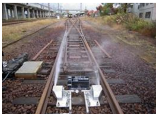
【温水ジェット式融雪装置の新設】
