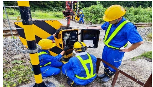
〈設備社員：踏切遮断機検査訓練〉
