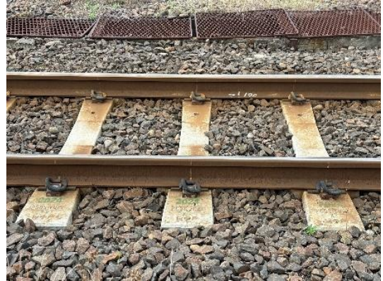
〈直江津駅構内 PC マクラギ化〉
