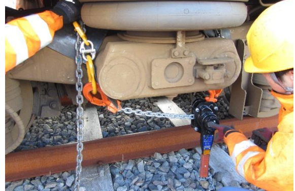
〈ルーカス使用による列車脱線復旧訓練（11月）〉
