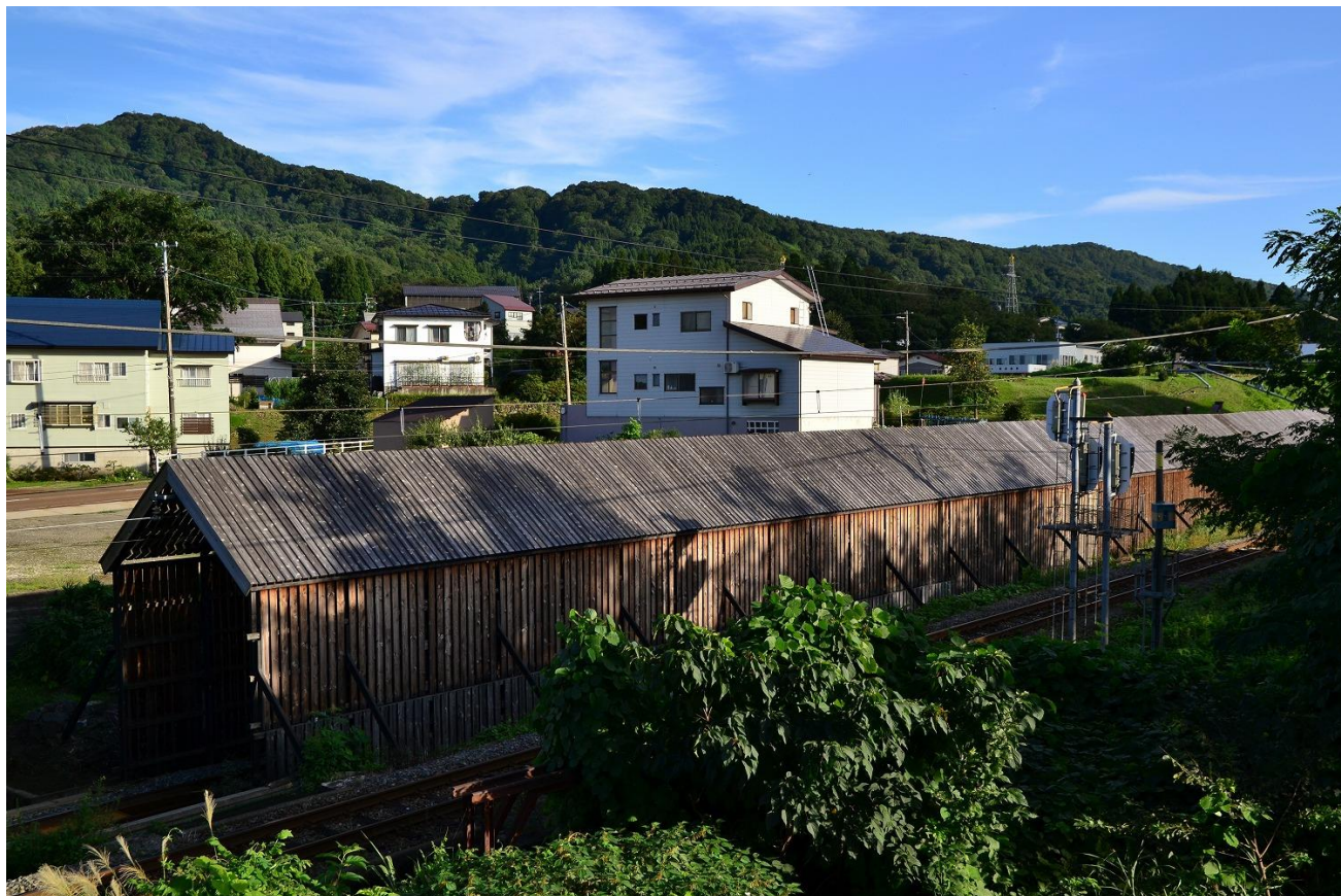
(7) えちごトキめき鉄道二本木駅スイッチバック線雪囲い
