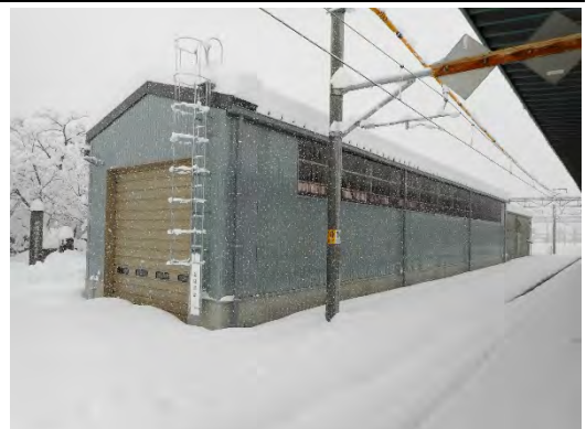
～投排雪車両車庫新設～
