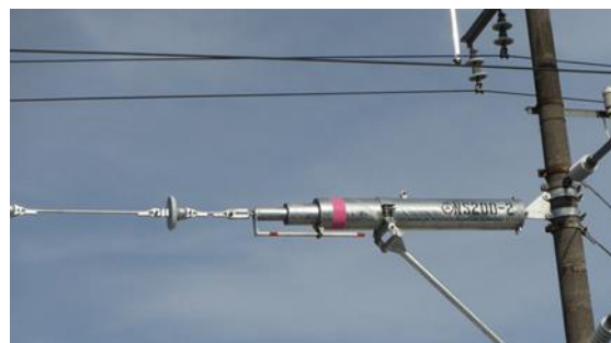
～自動張力調整装置取替～
