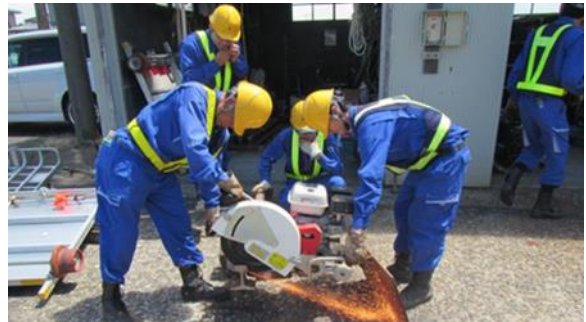
～設備社員：レール切断機取扱訓練～
