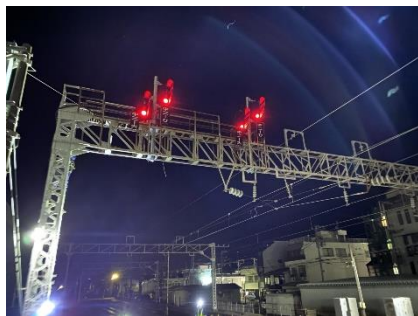
～色灯信号機構取替（LED化）～
